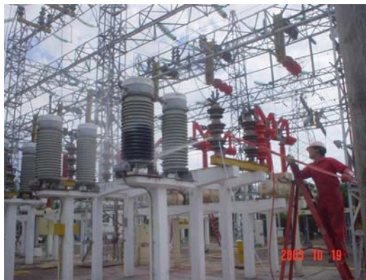
Fig. 1. Limpieza de los aisladores eléctricos.
