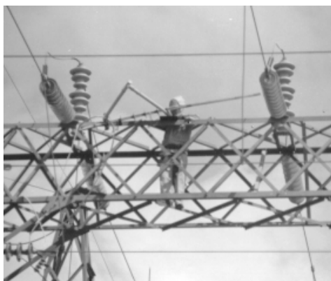
Fig. 1. Operador limpiando aisladores eléctricos
